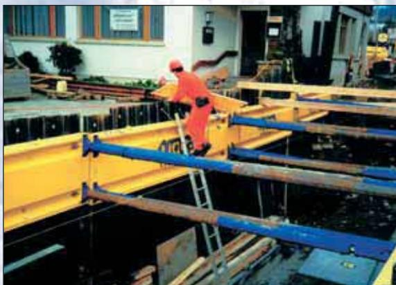
Систему SBH с двойной направляющей и роликовой распоркой в комбинации со шпунтом часто применяют в условиях пересекающих коммуникаций.
