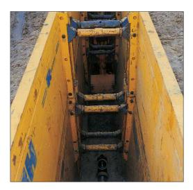
Быстрая установка и демонтаж при помощи пальцев и защелок.
